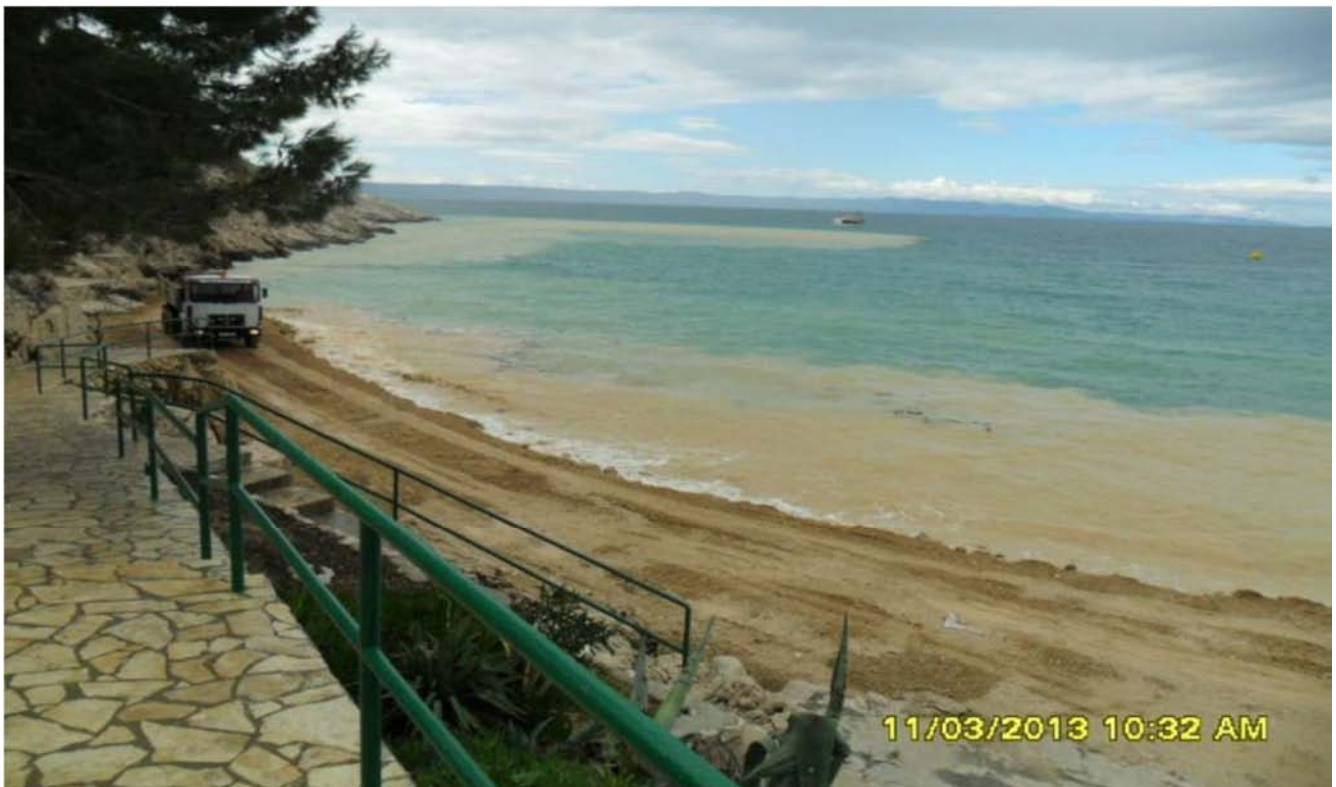
Slika 14. Stanje lokacije za vrijeme izgradnje trupa platoa plaže (11.3.2013.; preuzeto s http://www.index.com ; Foto: Zlatko Marinović)
